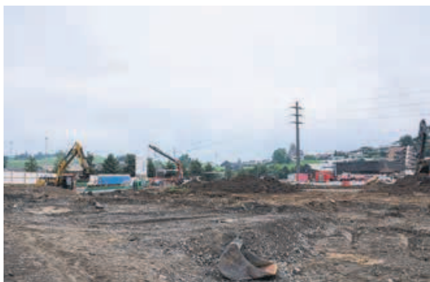
Auf dem Bauplatz der OBS in Wollerau wird viel Erde bewegt.
